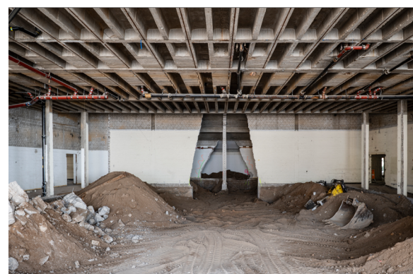
... und hier nach Beginn der Spezialtiefbauarbeiten.
