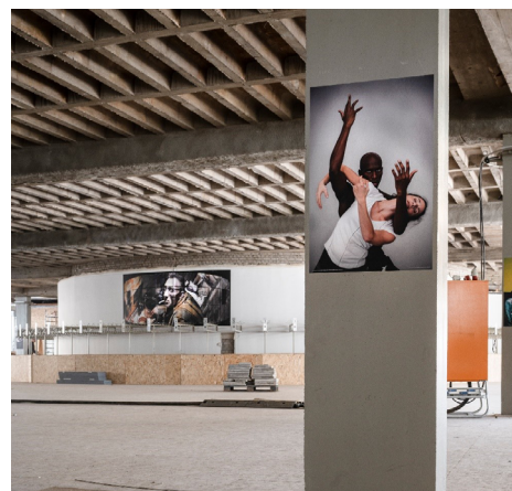
Das Untere Foyer nach dem Rückbau
